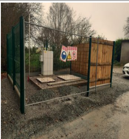
Construction du poste de relevage Atelier communal à Taule
