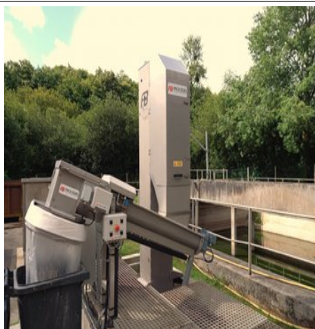
Remplacement du dégrilleur à la STEP de Lanmeur
