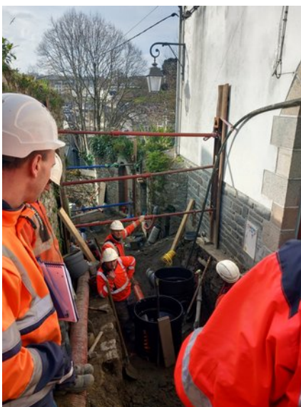
Mise en séparatif quartier Auguste Ropars à Morlaix
